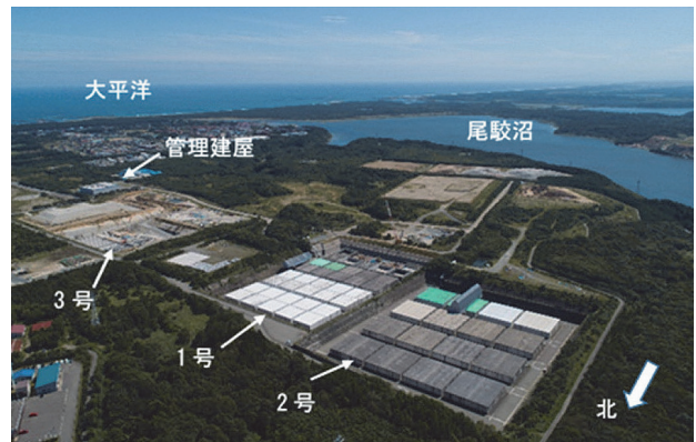
埋設センターの全景
