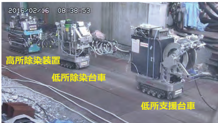
3号機R/B内への進入風景
