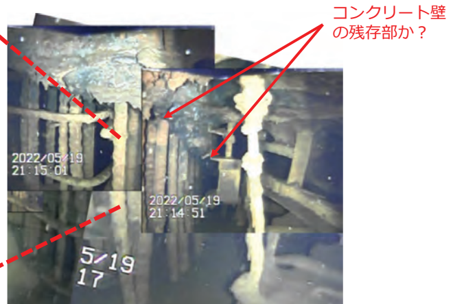
写真2. ペDESTAL外部から見えているコンクリート残存部
