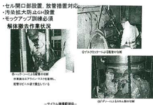
図 2.1-2 酸回収蒸発缶の解体作業
