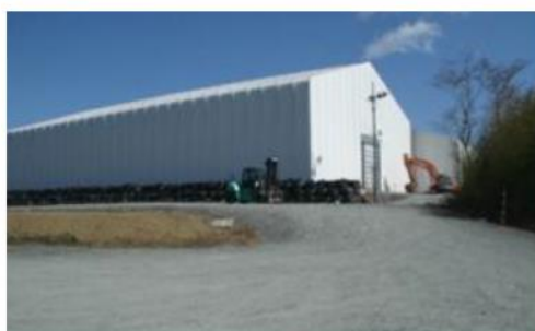
建屋上部ガレキ保管テント
