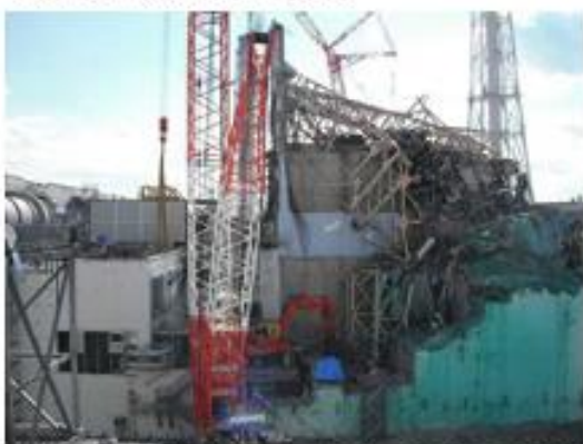
(大型がれき撤去前：平成24年2月21日撮影)
