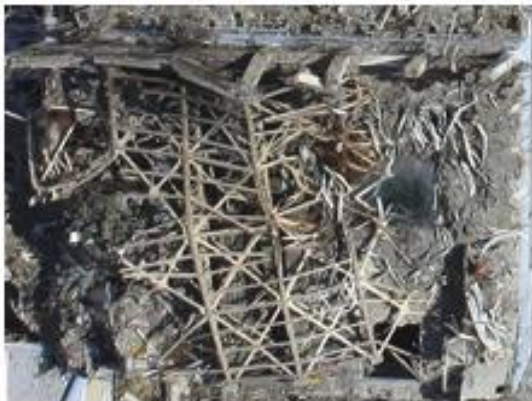
(大型がれき撤去前：平成23年3月24日撮影)
