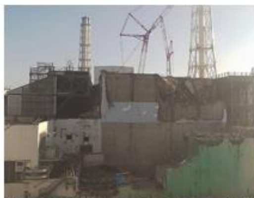
(大型がれき撤去後：平成25年10月11日撮影)
