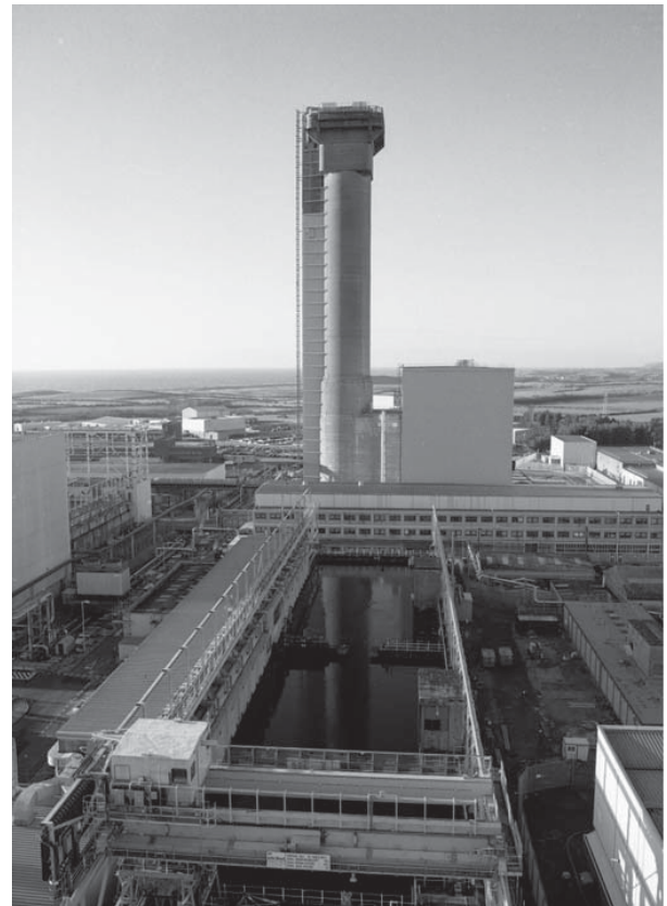
屋外燃料貯蔵プールとウインズケール炉の煙突(提供：NDA)
