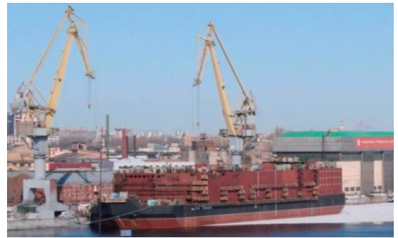
建造中の海上浮揚型原子力プラント
