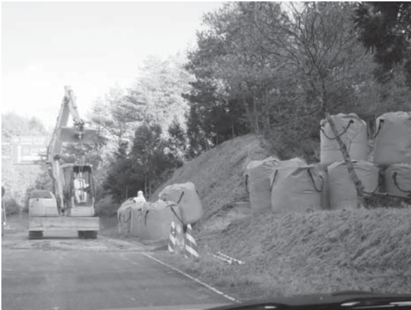
避難指示解除準備区域における山林除染の例(除染で発生した汚染物がフレコンバッグに収納されている)
