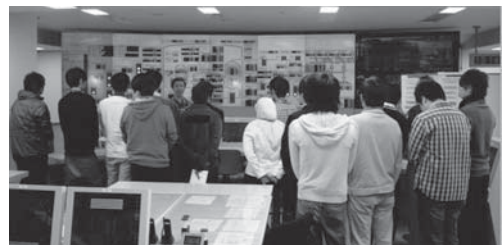
第7図 北電における全交流電源喪失模擬訓練
