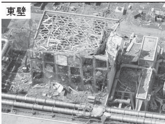
第17図 爆発後の原子炉建屋(4号)
