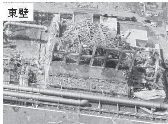
第15図 爆発後の原子炉建屋(3号)
