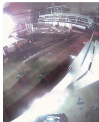
福島第一原子力 発電所2号機 原子炉建屋5階 (2月、東京電力HP)
