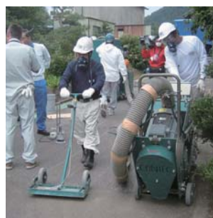
アスファルト、コンクリート表面切除用のショットブラスト機
