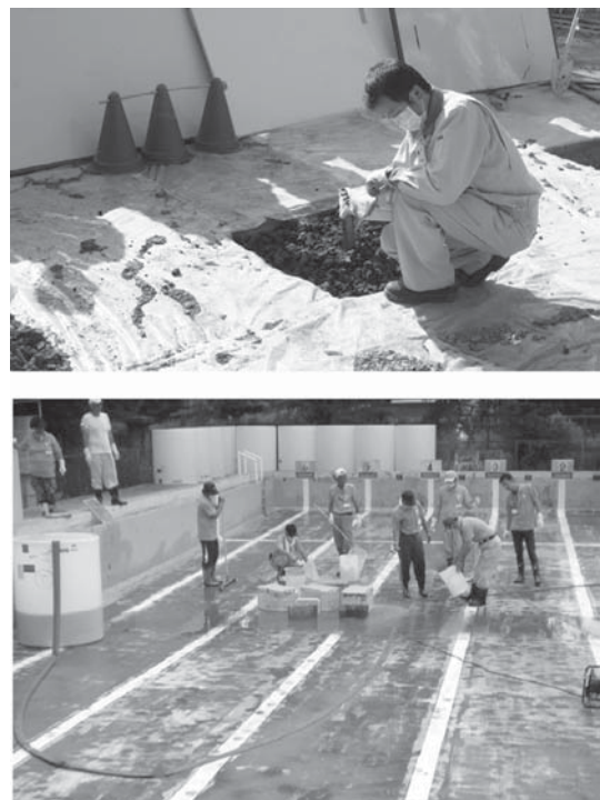
第2図 上図は校庭の土壌中の空間線量率を調査しているところ、下図はプールの除染作業の様子
