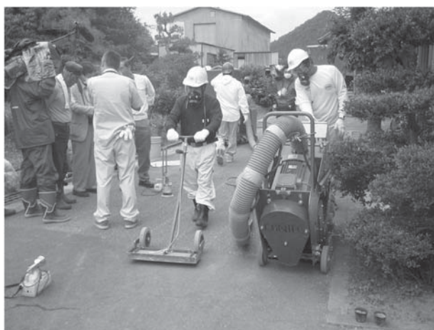
第3図 アスファルト、コンクリート表面切除用のショットブラスト機(株アトックスによる写真提供)
