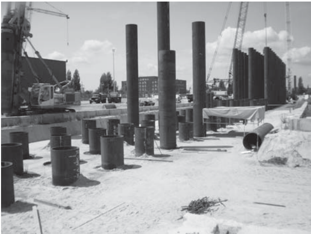
第3図 NSC支持レールの基礎工事(2011年7月12日撮影)
