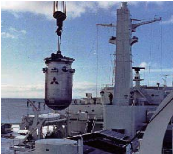
第1図 「むつ」への原子炉容器吊り込みの様子
