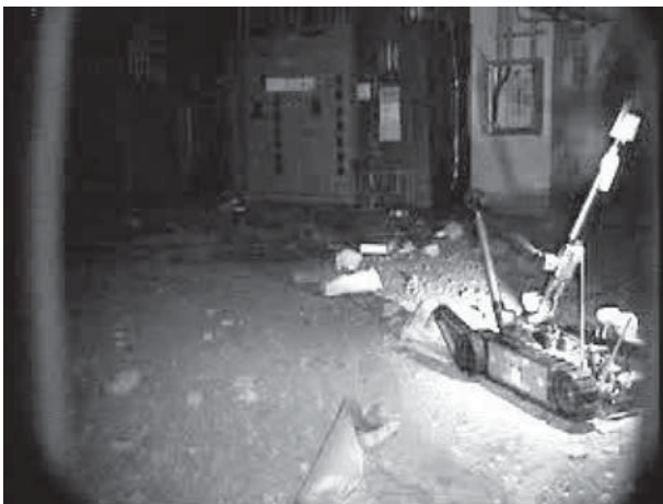
福島第一原子力発電所 原子炉建屋内のようす（東京電力 HP）
