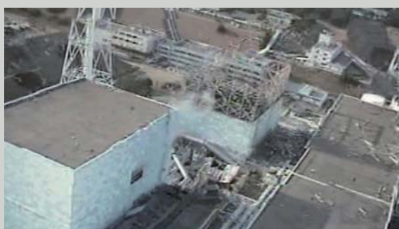
1, 2号機原子炉建屋(東京電力 HP)
