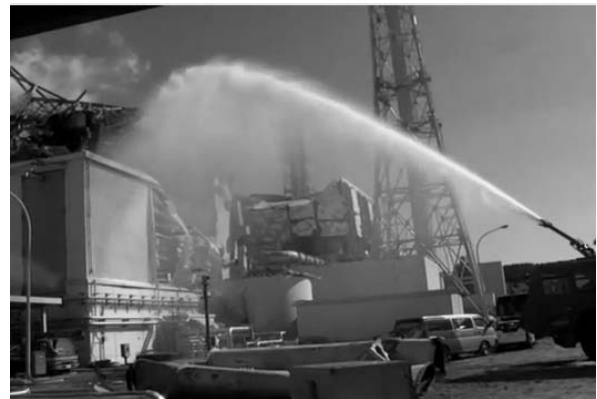
福島原発への放水作業(防衛省 HP より)
