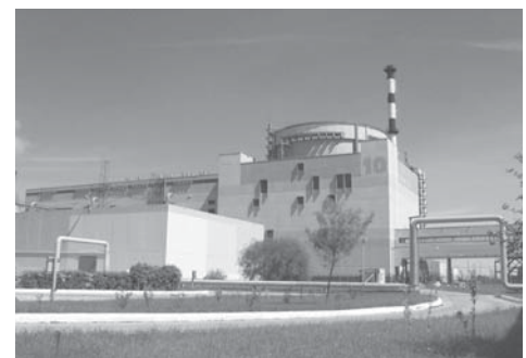
第2図 ロブノ原子力発電所 ©Energoatom
