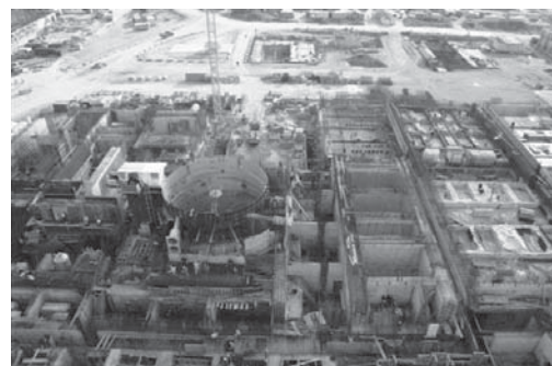
第2図 BN-800建設サイトの状況(2009年) 3)
