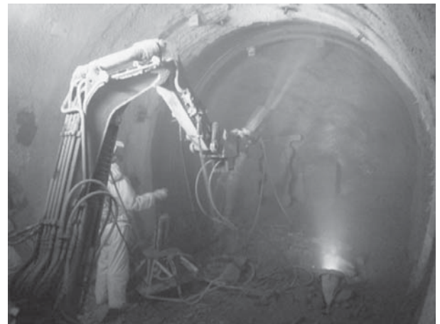
HFSCの施工状況(吹付けの厚さ：約20cm、坑道内径：高さ3m、幅4m)
