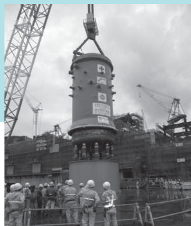
つり込み作業中の原子炉圧力容器。重さは820トンもある。(News p.7)
