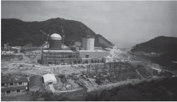
高浜1・2号機建設当時の風景 (昭和47年9月撮影。高浜発電所提供)
