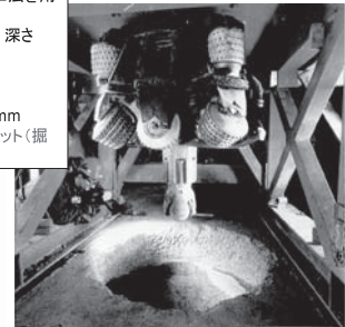
第12図 プル・リーミング工法：KBS-3Hのための横置き処分坑道の掘削試験 7)
