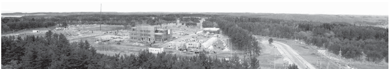
第3図 青森六ヶ所村のITER BA建設現場
