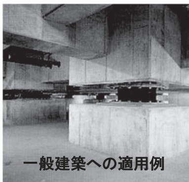
第3図 免震装置の適用例
