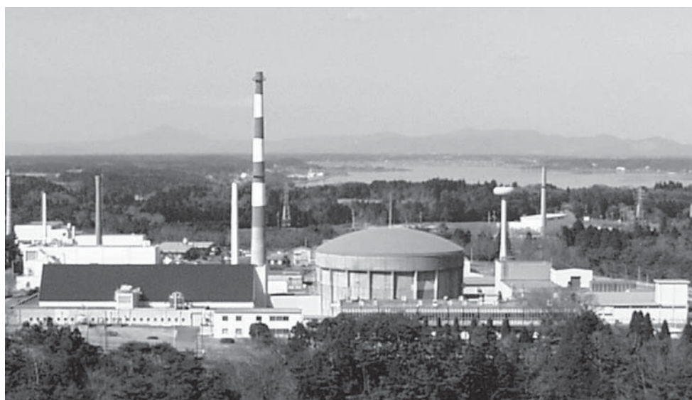
改修が本格化する材料試験炉(JMTR)
