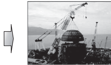
第 9 図 CV の建設工法の改良
