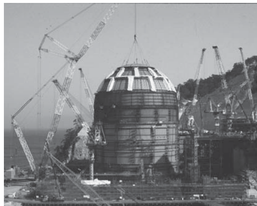
第1図 建設工事状況
