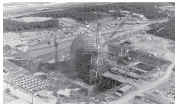
第4図 格納容器の建設(1971年9月)
