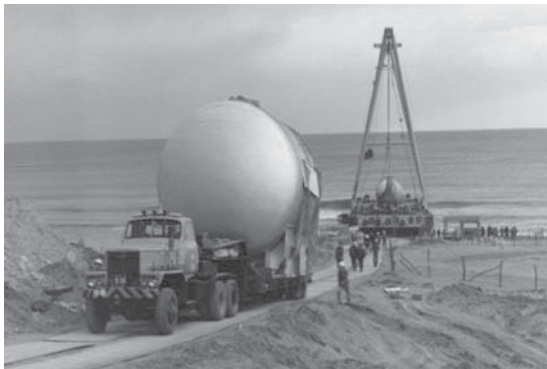
第5図 1次系ダンプタンクの陸揚げ(1971年12月)
