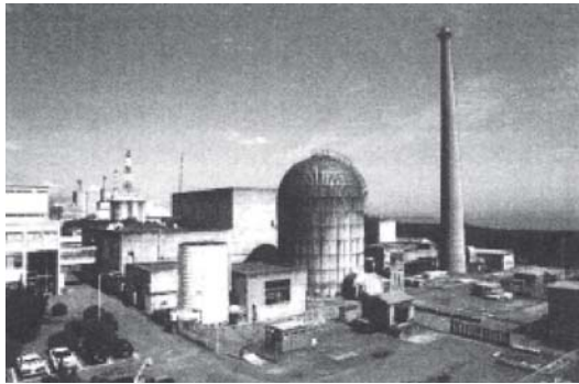
解体前(電気出力12万5,000 kW)
