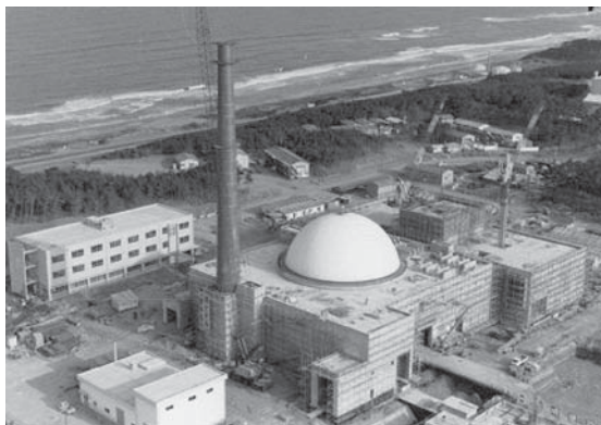
第6図 原子炉建家の建設(1973年3月)
