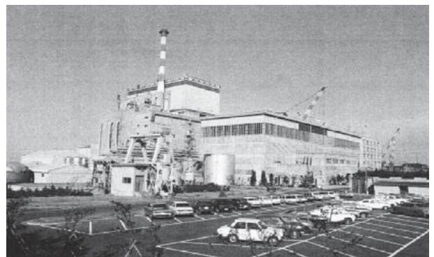
第5図 原電東海コールドホール型発電炉 電気出力(発電端)166 MW、(送電端)157 MW
