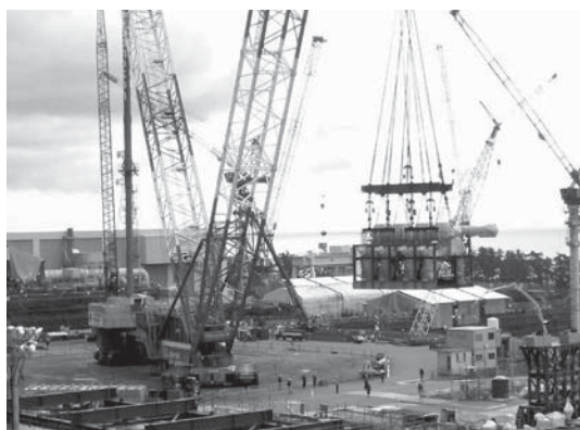
第3図 大型モジュールによる先進建設工法
