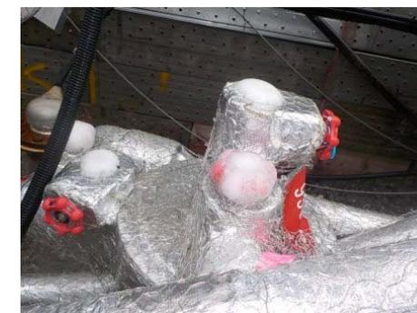
凍結管(バルブ)の凍結状況
