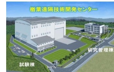
楢葉遠隔技術開発センター (モックアップラボ)
