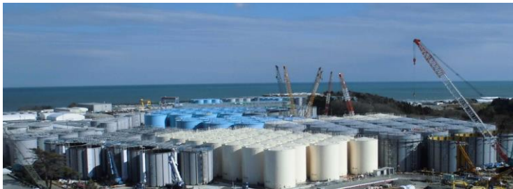
【タンク増設作業】
