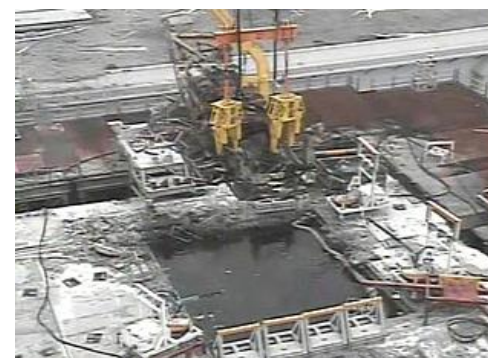
2013年8月2日 使用済燃料プール内の最大のガレキである燃料取扱機を撤去
