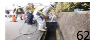
〔写真〕 技術実証の様子
