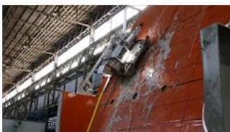
S/C上の亀裂、漏えいを調査
