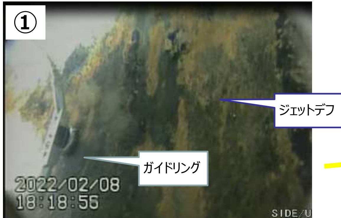
ガイドリング①設置状況（2月8日午後6時18分設置完了）
