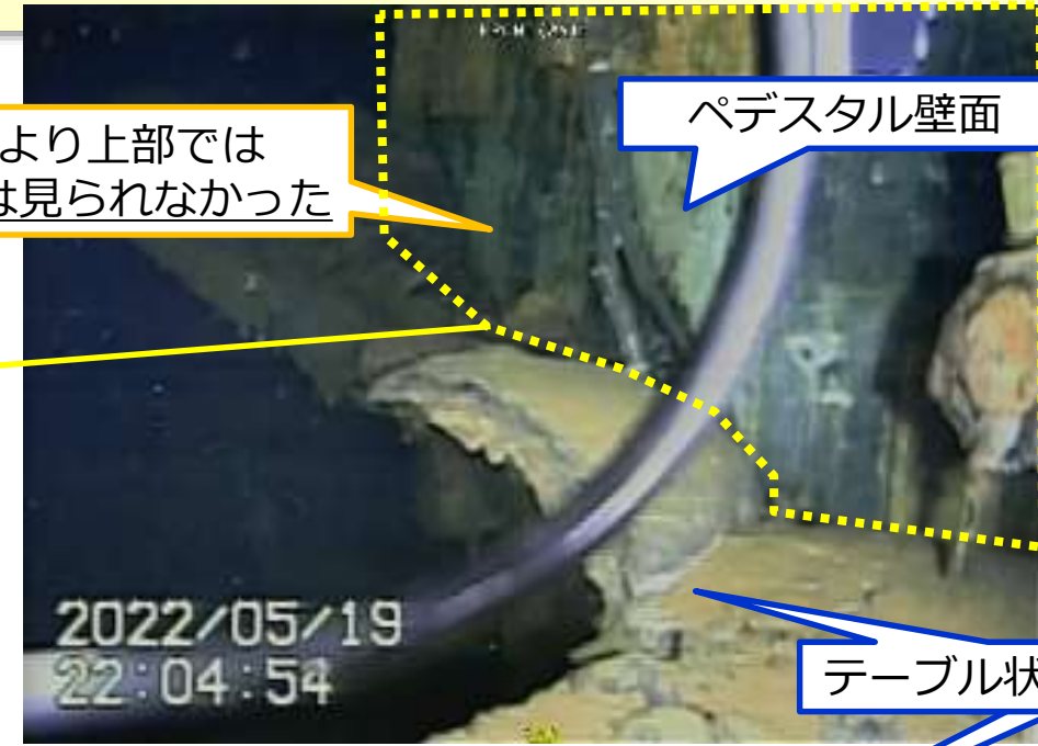
写真2.ペDESTAL開口部(右側基礎部)の堆積物より上部の状況
