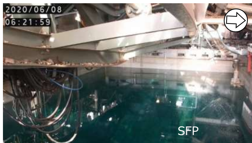
養生バッグ投入前
