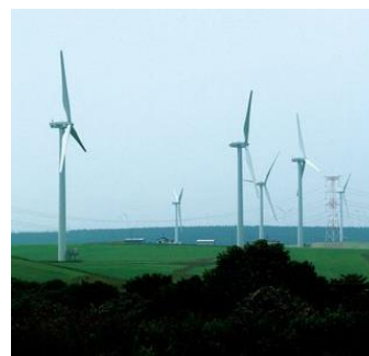
風力発電所（写真） （北海道 稚内市）
