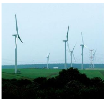
風力発電所(写真)
