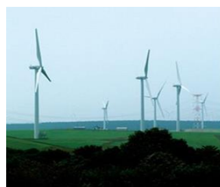
風力発電所 (写真)
