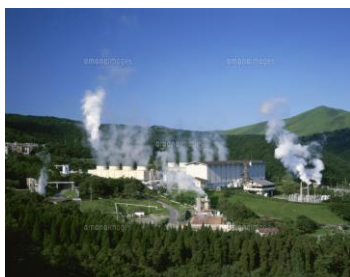
地熱発電所(写真) (大分県九重町)
