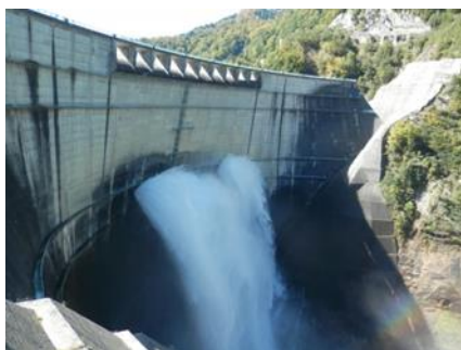
水力発電所(写真)
