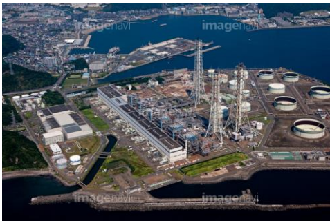
火力発電所（写真） （神奈川県横浜市）
