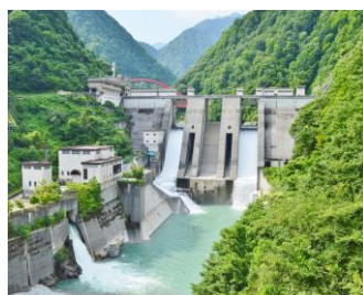
水力発電所 (写真)
