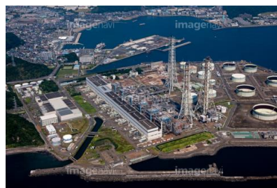
火力発電所(写真) (愛知県 知多市)
