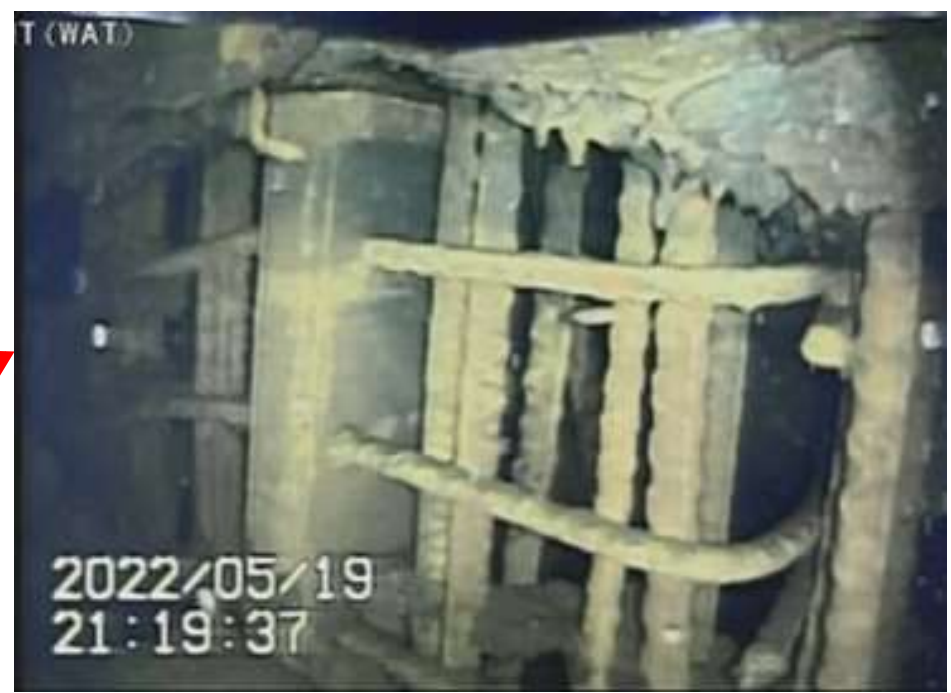
ペデスタル開口部（右側基礎部）の状況
