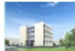
廃炉国際共同研究センター 国内外の英知を結集し、研究開発と人材育成を一体的に進める拠点
