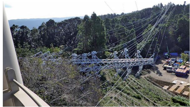
図1 2019年台風15号鉄塔被害状況 (出典：経産省WG資料 4) )
