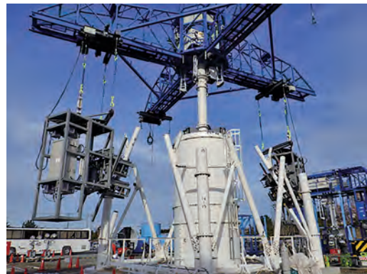
図9 モックアップの状況
