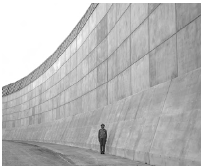
図2 津波に備えた高さ22mの防波壁
