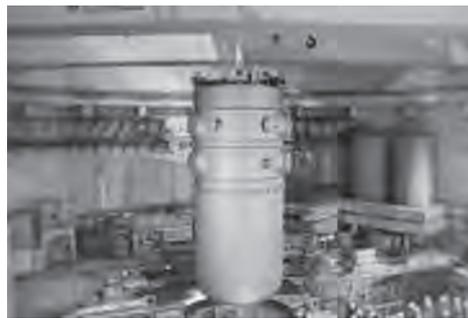
図5 オストロベツ1号機の原子炉容器据付
