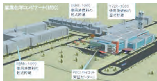
鈹業化学コンビナートにおける使用済み燃料管理関係施設
