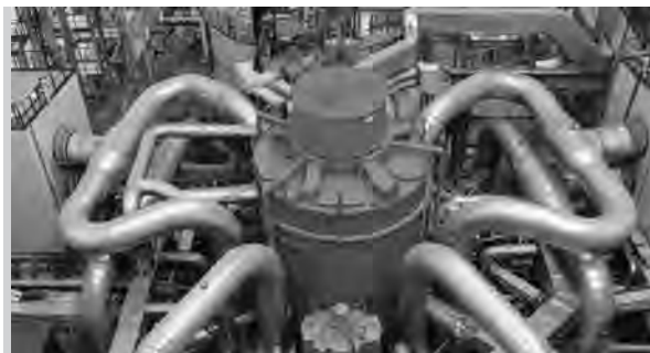
図 BN800 の炉室内写真(Booklet of Beloyarsk NPP より)中央の円筒構造の下方に炉心が位置し、その周囲に曲線を描くように配置された配管が、6 基ある中間熱交換器からの 2 次系ホット、コールドレグである。 (Beloyarsk NPP から転載許諾取得済み)
