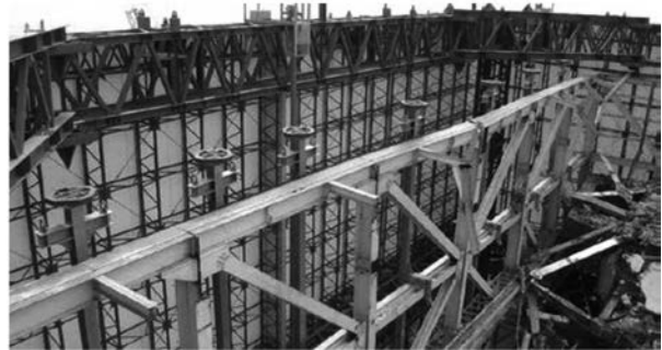
図11 ミストノズルユニット設置状況(東面) (東面7箇所、西面6箇所)
