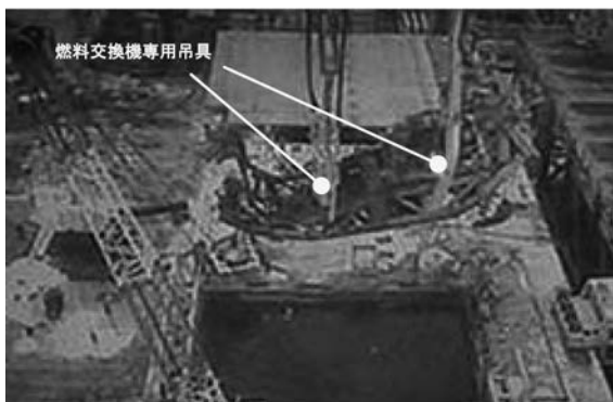
図5 燃料交換機吊上げ状況
