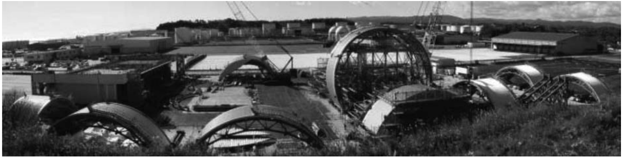
図4 鉄骨ユニットのサイト外仮置き状況
