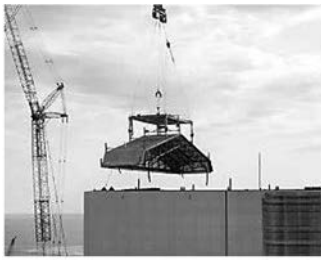
図3 屋根パネル撤去状況
