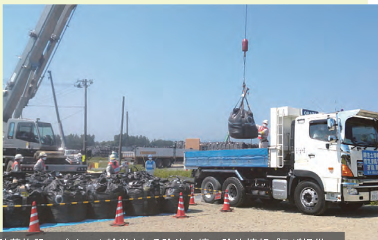
仮置場から中間貯蔵施設へパイロット輸送される除染土壌－除染情報プラザ提供
