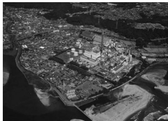
第1図 常磐共同火力(株) 勿来発電所全景
