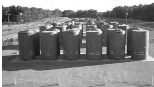
第4図 米国におけるコンクリートキャスク貯蔵例 上：NAC社提供，下：Holtec社提供
