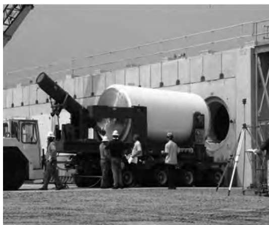
第5図 米国における横型コンクリートサイロ貯蔵例 (使用済燃料の入ったキャスクを横型のコンクリートサイロに装荷する作業(TN社提供))
