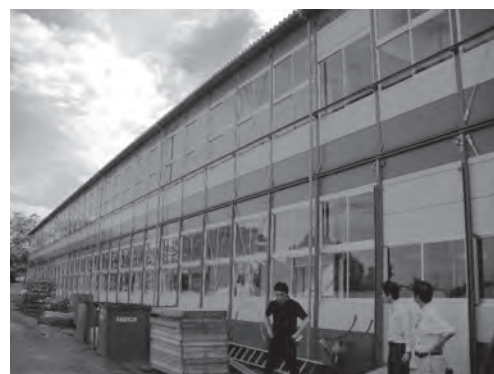
写真1 被災地の実況を調査する委員会メンバーと福島県高校教諭(福島県立原町高校のグラウンドに建設中の仮設校舎 2012年6月17日撮影)
