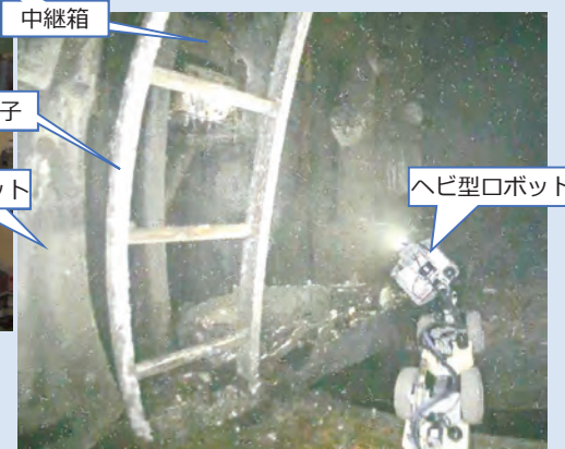
CRD交換用開口部前の状況(梯子)
