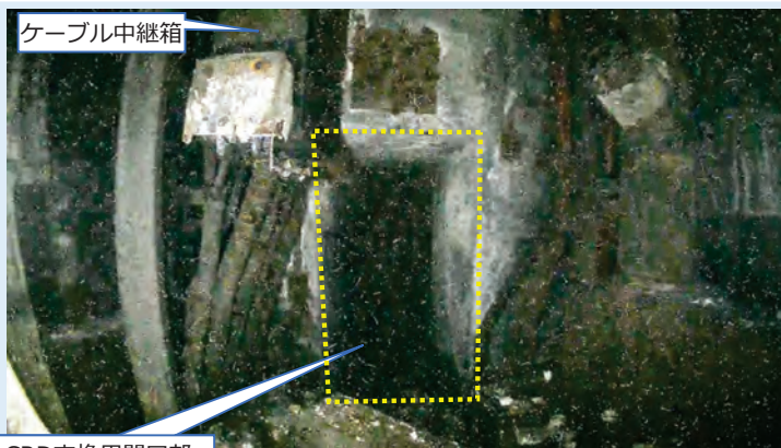
ヘビ型ロボット待機位置 1号機PCV内1FL 拡大図(概略)
