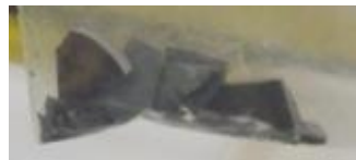
2号機コア表面塗膜 (2RB-DE-C2)
