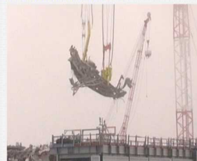
<燃料交換機撤去作業の状況>
