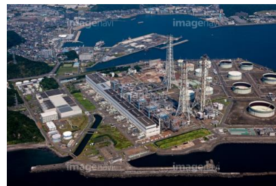
火力発電所(写真) (愛知県 知多市)
