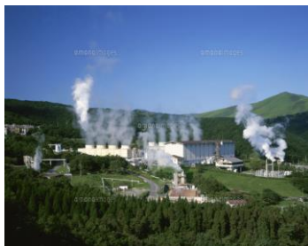
地熱発電所(写真) (大分県九重町)
